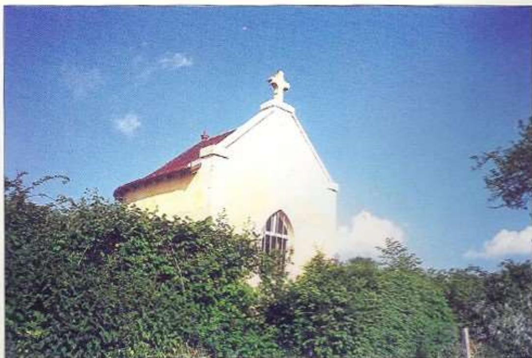
Chapelle Saint-Amable restaurée
